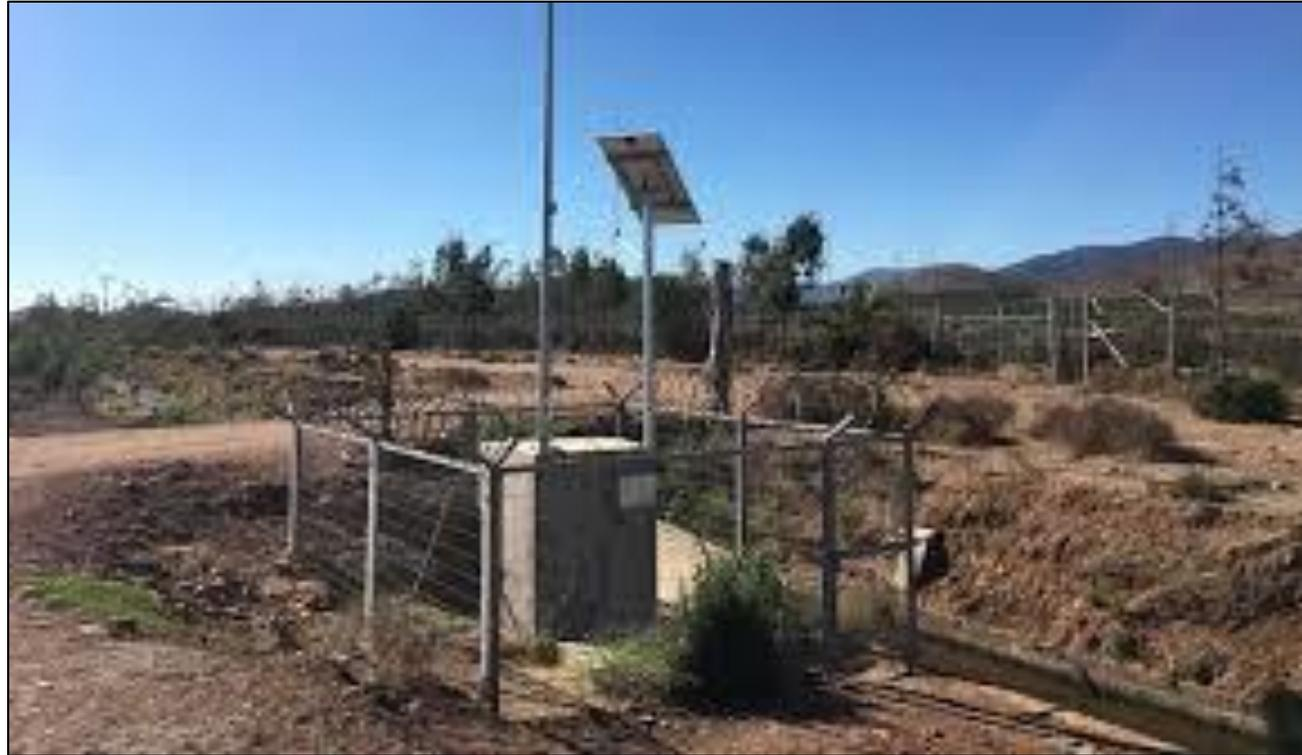
**Sistema de telemetría instalado en una estación de aforo de un canal**
